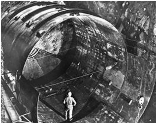
So sollten andere Teilchen der kosmischen Strahlung abgeschirmt werden, wohingegen die Neutrinos ohnehin durch die Erde hindurchfliegen können. Nachdem auch sämtliche Einflüsse der Umgebungstrahlung beseitigt oder zumindest herausgerechnet werden konnten, wurde durch Detektieren der Argon-Atome und der Elektronen die Anzahl der Neutrinos gemessen, die diese Reaktion erst ermöglichen. Die theoretischen Erwartungen für die Anzahl detektierter
